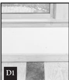
Installation avec décalage de 9 po
